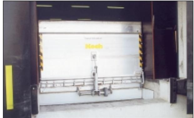
► Sonderausführung Typ SKB, angelenkt innerhalb der Lagerhalle (hinter dem Tor).
