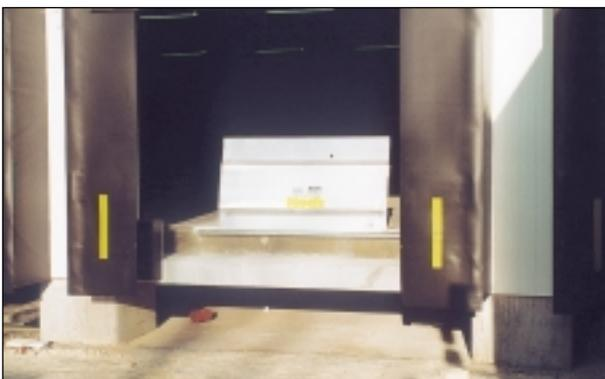
► Typ KBSS. Brücke ist in der Halle (hinter dem Tor) angelenkt, mit Unterfahrbarkeit für Ladebordwände.
