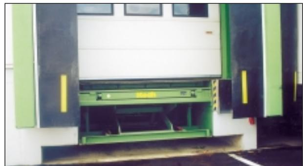
► bildet immer mit der LKW-Ladefläche eine horizontale Ebene ► dadurch Verwendung von Flurförderfahrzeugen ohne Mastneigung auch bei vollbeladenem LKW möglich ► Beladung auch bei sehr niedrigen Ladeflächen-Höhen
